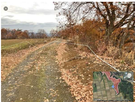
図7. 高圧電力鉄塔付近で、境界線が歪んでしまった例
