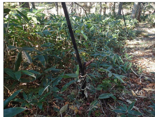
【写真2：防鹿柵の補修状況】
