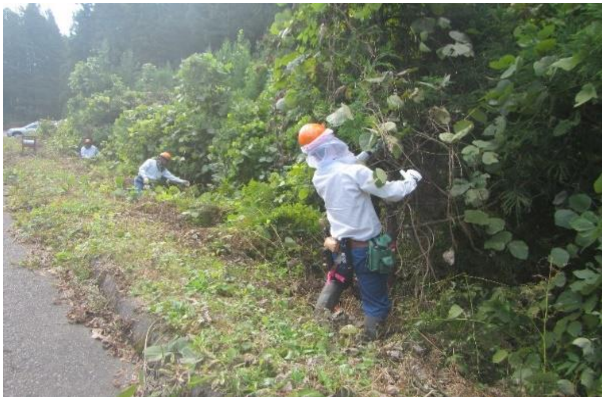
作業の様子（令和5年10月11日）
