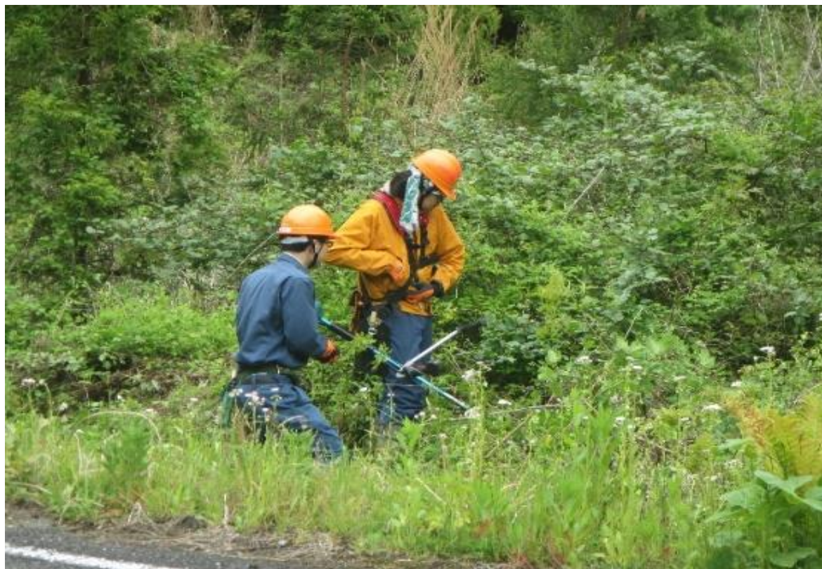
作業の様子（令和5年5月15日）
