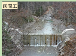
嵩上げ2基完了、1基新設中
