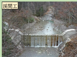
嵩上げ2基完了、1基新設中
