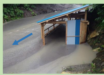
下流の天然温泉被災状況 (R3.8)
