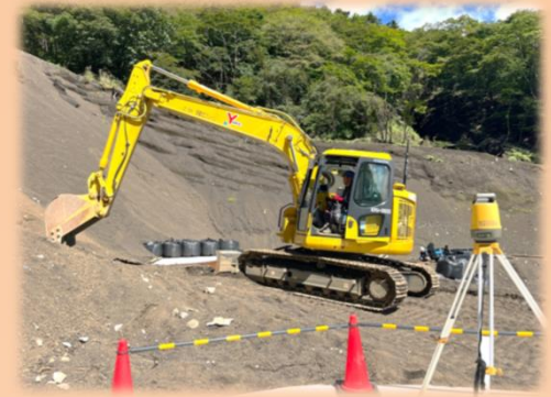
ICT建設機械を用いた掘削の様子
