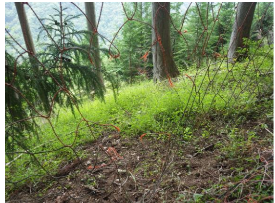
図-1 損傷したシカ柵の網
