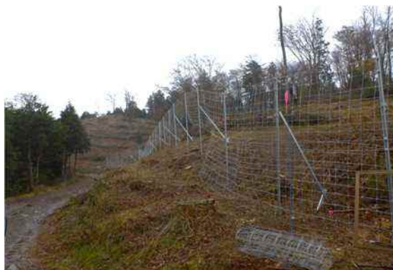
（写真 1）獣害防護柵の設置
