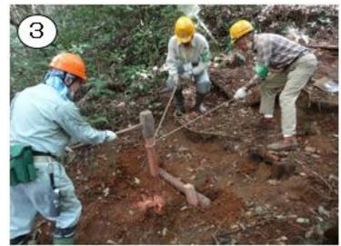
(写真 8-3 角材を垂直に設置)
