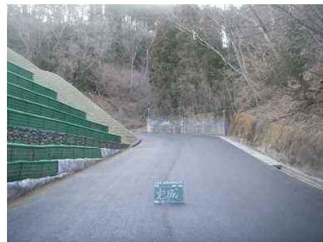
写真3 道路の改良状況
