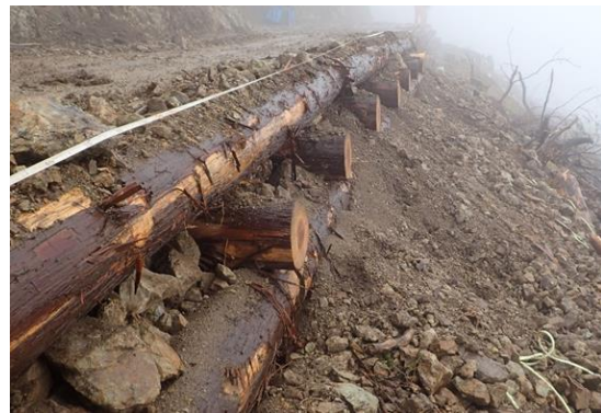
図5 路面補強工の実施
