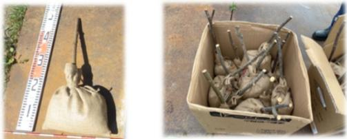
崩壊地の下流域で採取したヤナギの枝を利用した工法 投下時の初期活着を促すため、赤玉土を詰めた麻袋に挿し木しています。「令和3年度実施」
