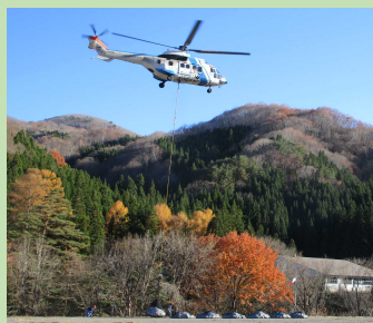
袋詰玉石の運搬
