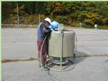
侵食防止剤をバケットに注入
