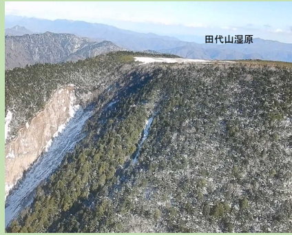
田代山山頂の田代山湿原と崩壊地（令和2年11月撮影）
