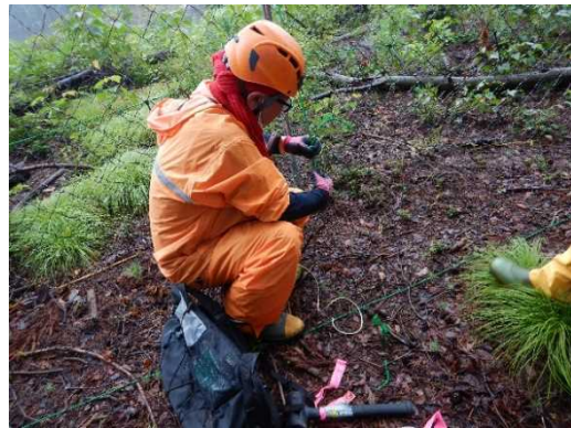
スカートネット補修
