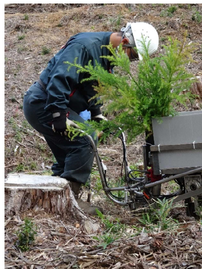
作業アタッチメントによる掘削
