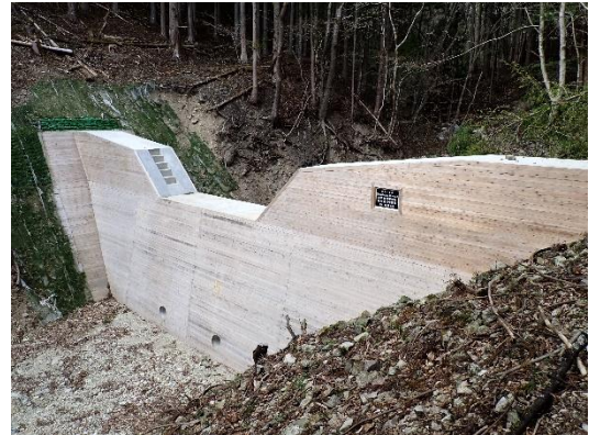
木製型枠を使った谷止工（那須塩原市上塩原）
