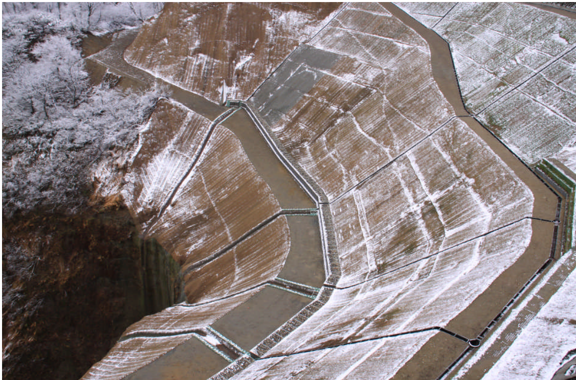
完成した山腹工
