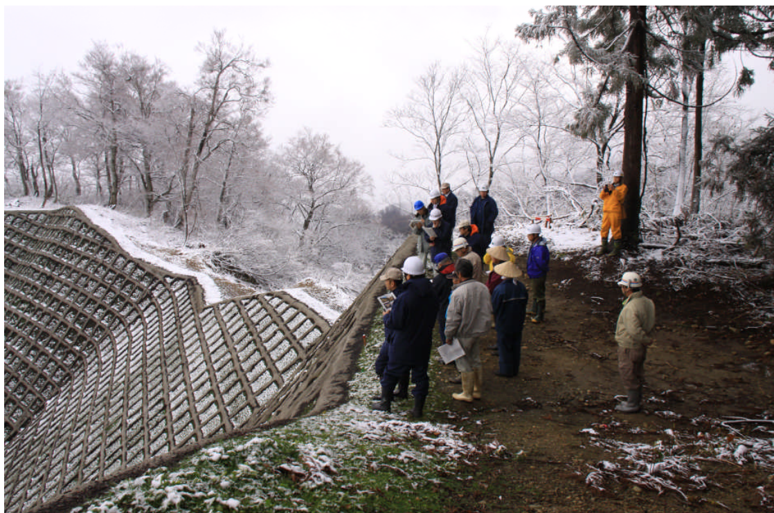
完成した治山工事現場を視察する参加者
