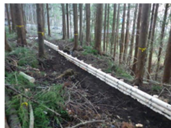
実証事業（丸太筋工）
