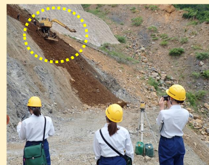
（RCM 工法による治山事業）
