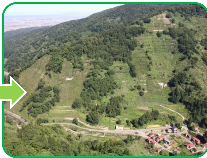
復旧状況（同左地区） （平成25年9月撮影）
