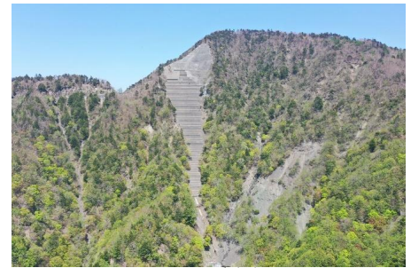
山腹工：小河内工区
