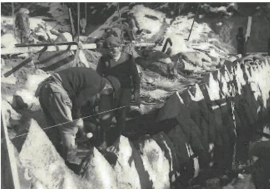
石積堰堤の施工の様子【東京神奈川森林管理署】
