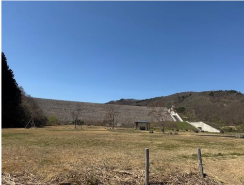
摺上川ロックフィルダム (福島市飯坂町)
