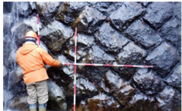
巨石積堰堤の現況(大又澤堰堤・下流側)
