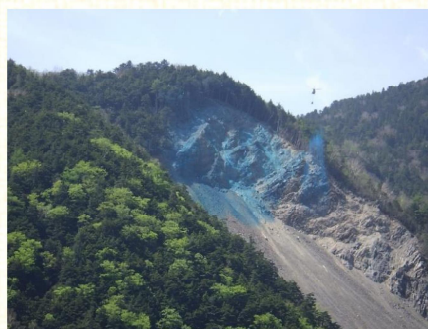
ヘリ施工の様子
