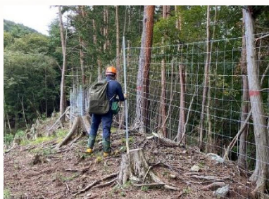
森林事務所職員による シカ防護柵の点検・補修作業
