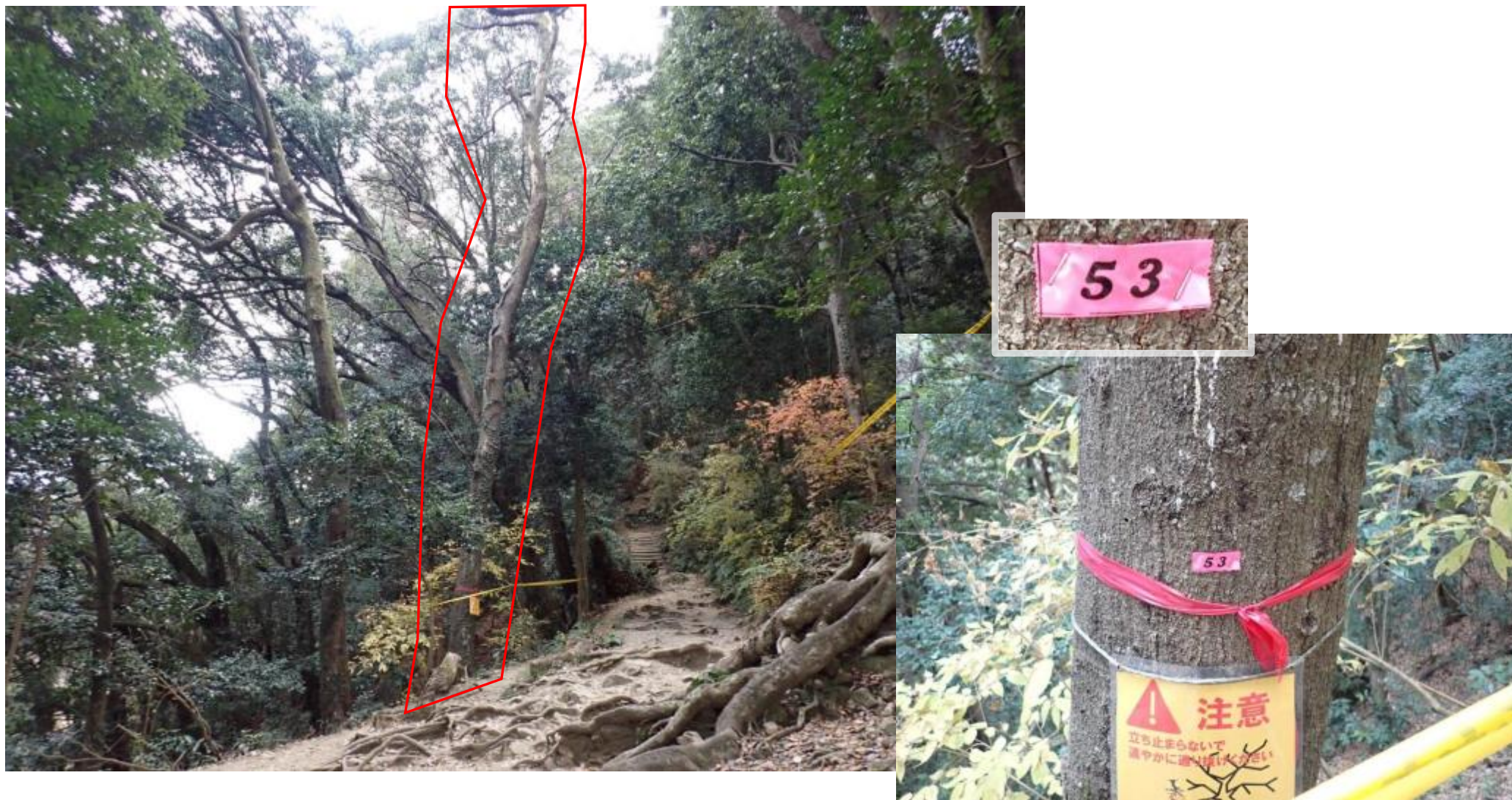
現況写真⑰(No.53)
