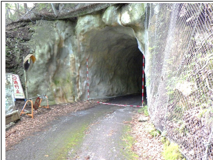
トンネル（入口側）
