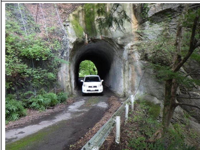
トンネル（出口側）
