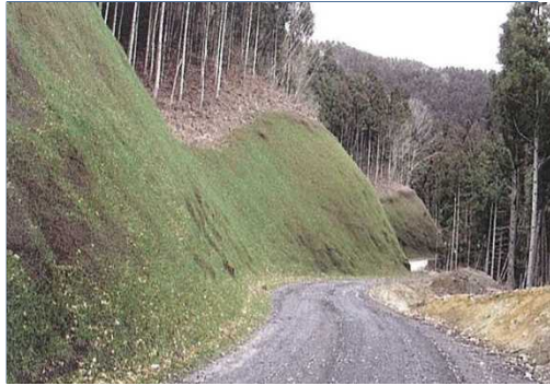
林業専用道新設 (棚倉町 那須道国有林)
