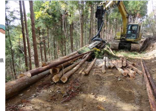
高性能機械による搬出・造材 (塙町 滝ノ入国有林)
