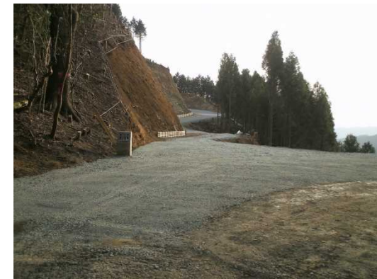
林業専用道新設工事
