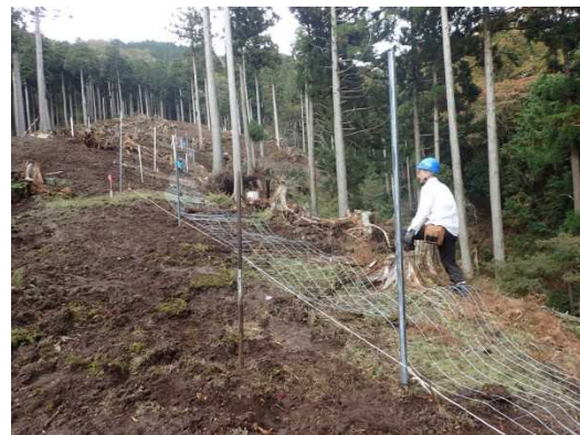
獣害防護柵設置作業
