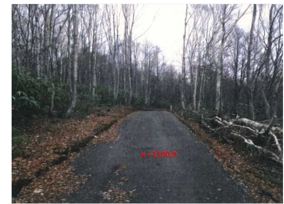
新設林業専用道
