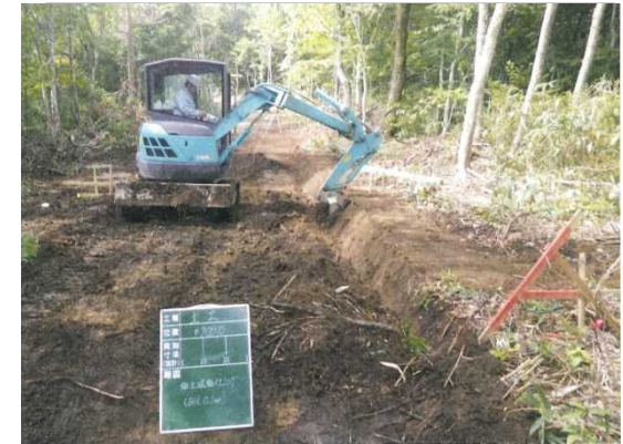
林業専用道新設工事
