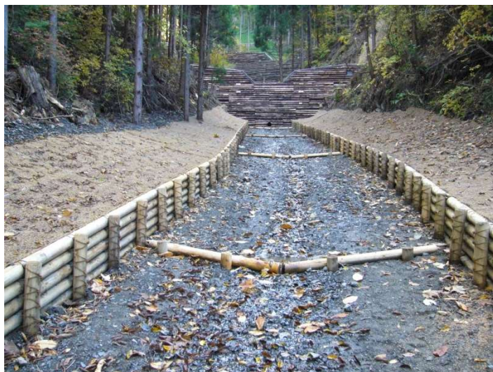
間伐木を利用した溪間工
