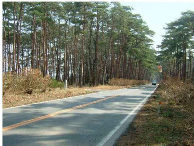
那須道路風景林(那須町)
