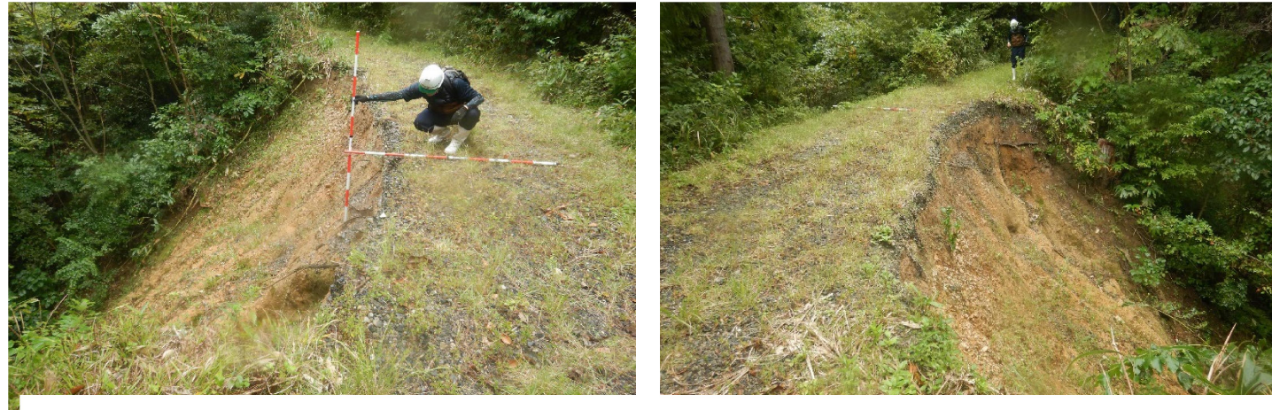
No.1 崩壊地 補修概要（仮設） 盛土：1,999m 3 、大型土のう 35 袋
