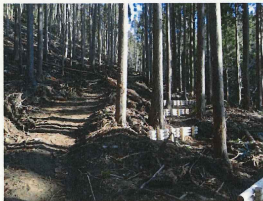
間伐事業実施と並行して、土砂流出防止を図るために設置した丸太筋工
