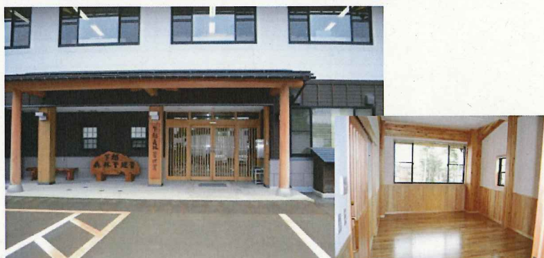
管内の木造庁舎（下越森林管理署）
