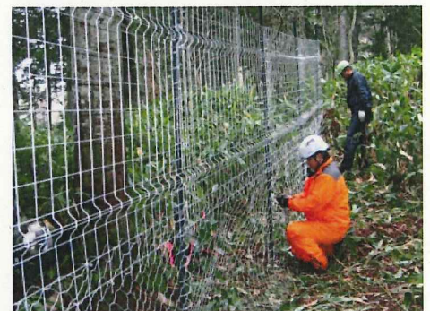
尾瀬の大江湿原におけるシカ防護柵の試験設置
