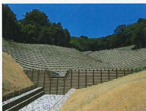
間伐材を積極的に利用した治山施設
