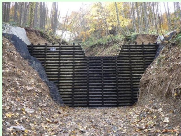
間伐材を利用した治山施設
