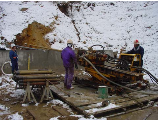
② 削孔作業
