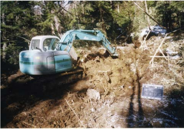
① 施工基盤の造成
