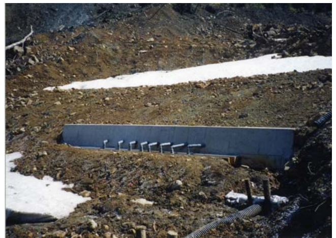
④ 土留壁・埋戻し・完成
