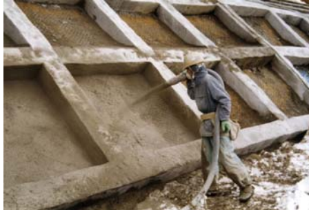
⑤ 枠内モルタル吹付
