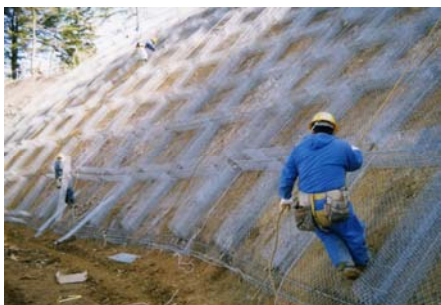
③ 枠フレーム組立
