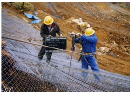
④ 主アンカー打ち込み
