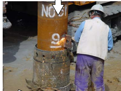
⑥ 吊金具の切除
