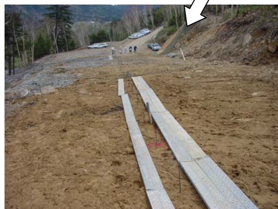
⑨ 埋め戻し完了
