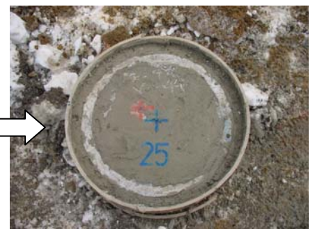
⑧ モルタル注入完了
