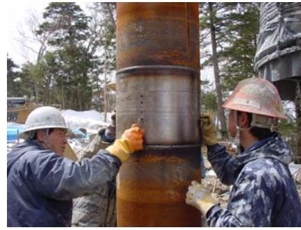
⑤ 鋼管杭の接続(ネジ締め)
