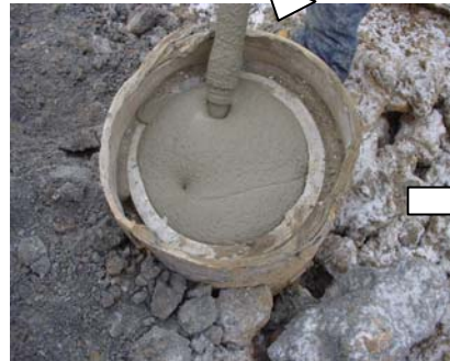
⑦ モルタル注入
