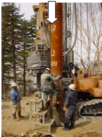
④ 鋼管杭の接続
