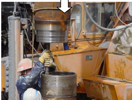
③ モルタル注入管の接続
