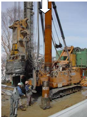
② 鋼管杭の挿入
