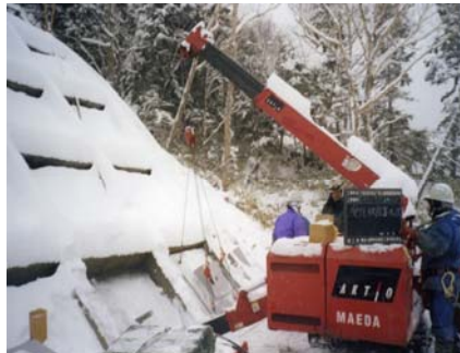
⑥ 受圧板設置
