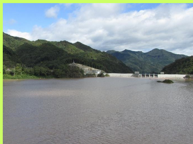
台風19号直撃後のハツ場ダム (令和元年10月13日撮影)
