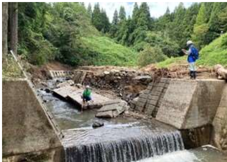
現地調査の様子
