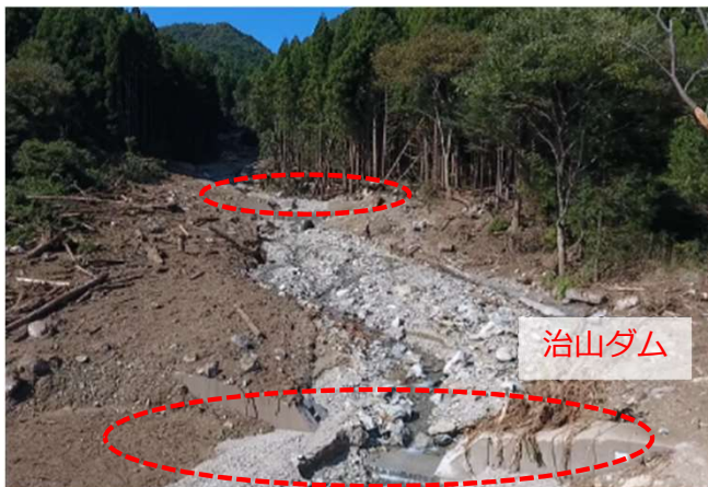
階段状に配置した治山ダムが溪床勾配を緩和させていたことにより、土砂や流木の流下エネルギーが減衰し、溪流内に停止させて流出を抑制
