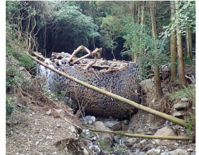
土石流捕捉ネットが土砂・流木を捕捉し、下流への流出を防止 (長崎県平戸市)
