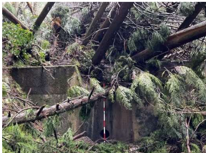
治山ダムが土砂・流木を捕捉し、下流への流出を抑制 (石川県輪島市)
