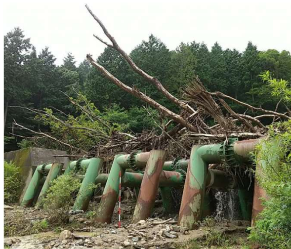
流木捕捉式治山ダムが土砂・流木を捕捉し、下流への流出を抑制
