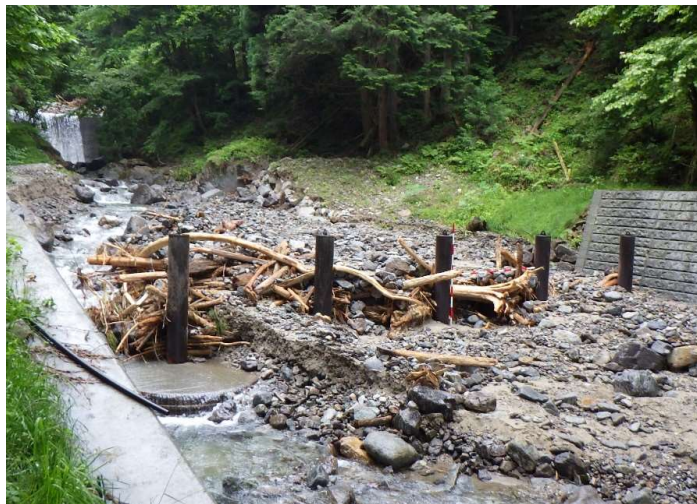
流木捕捉式治山ダムが土砂・流木を捕捉し、下流への流出を抑制 (長野県天龍村)
