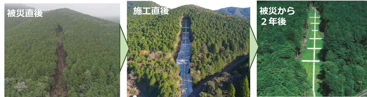
災害関連緊急治山事業による復旧（鹿児島県南九州市）
