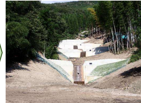
上流の不安定土砂の流出等を防止するため治山施設を設置
