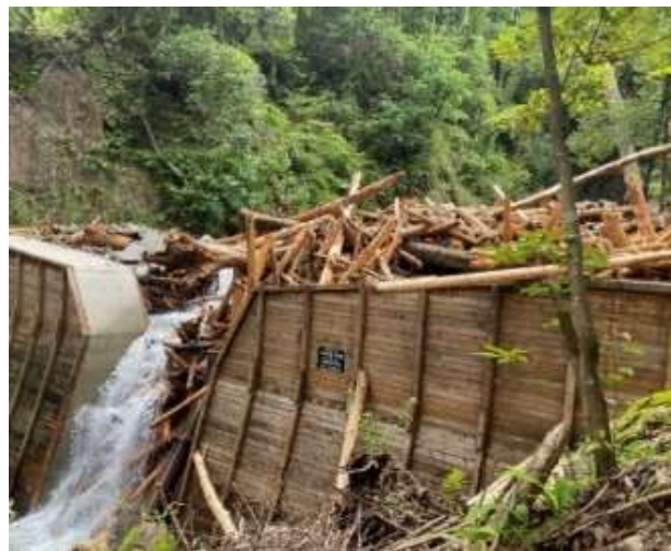
流木捕捉式治山ダムが土砂・流木を捕捉し、下流への流出を抑制
