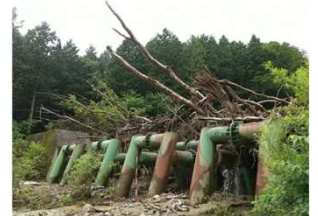
流木捕捉式治山ダム
