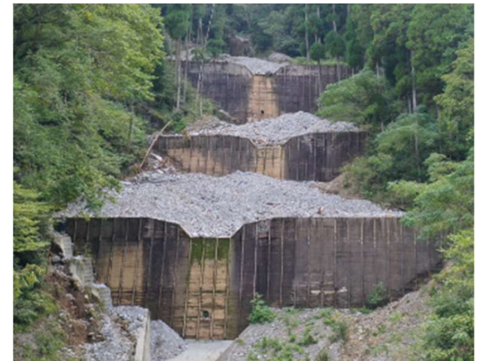
治山ダムが土砂を捕捉し、下流への流出を抑制
