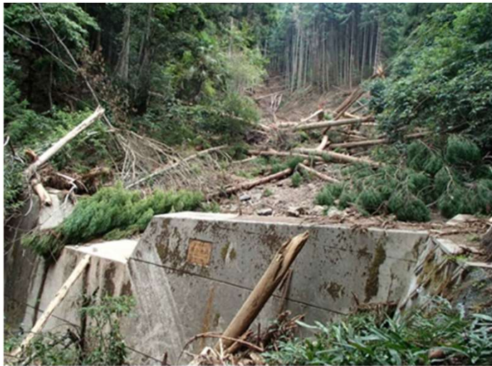
治山ダムが土砂・流木を捕捉し、下流への流出を抑制 (京都府福知山市)
