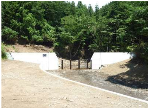
流木捕捉式治山ダムの設置（静岡県）
