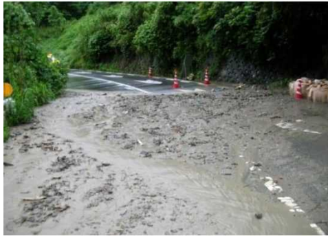
崩落発生後（国道への土砂流出）
