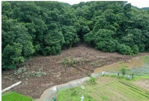
崩落後の土砂流出状況
