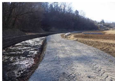
応急対策工事後（流出土砂の撤去）
