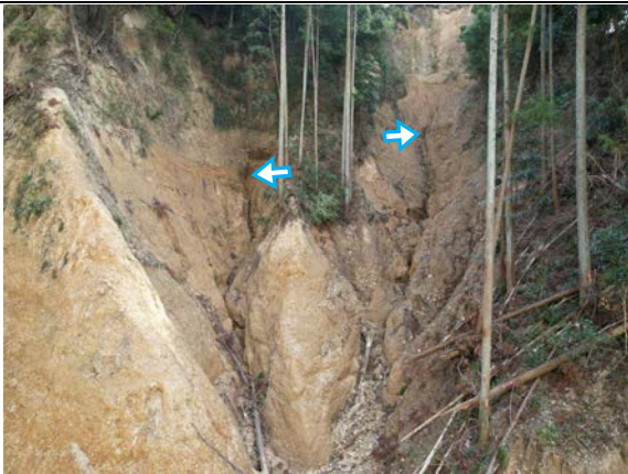
溪流内の侵食状況と湧水点とみられる凹地
