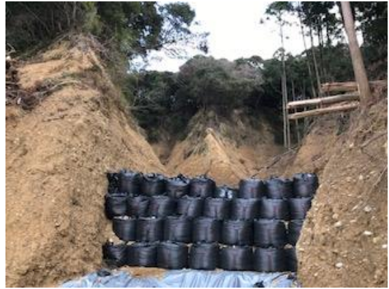
谷出口の応急対策施設設置状況
