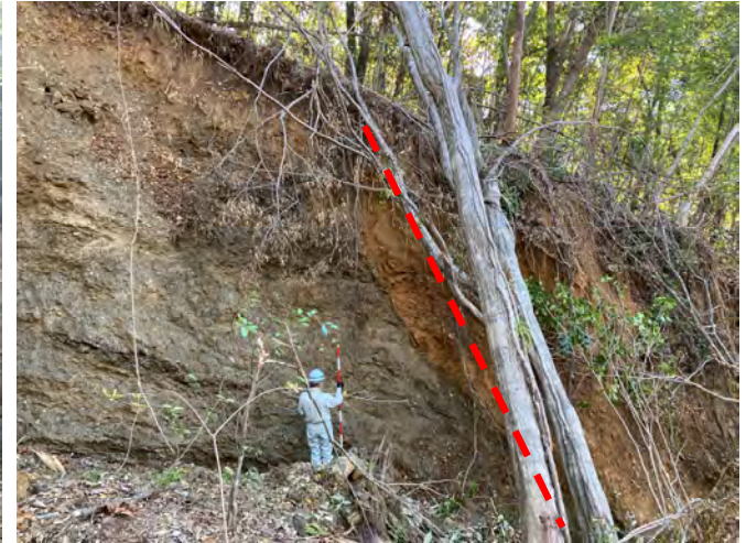
⑤地層境界 (③の道路から上部, 溪岸浸食5m)
