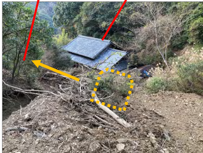
②被災した家屋 (上流から)
