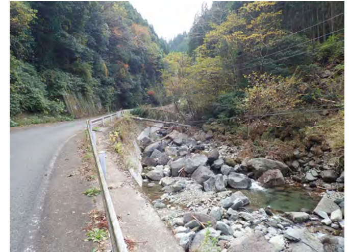
⑤崩壊斜面下部の溪流状況 (電信柱が倒されている)
