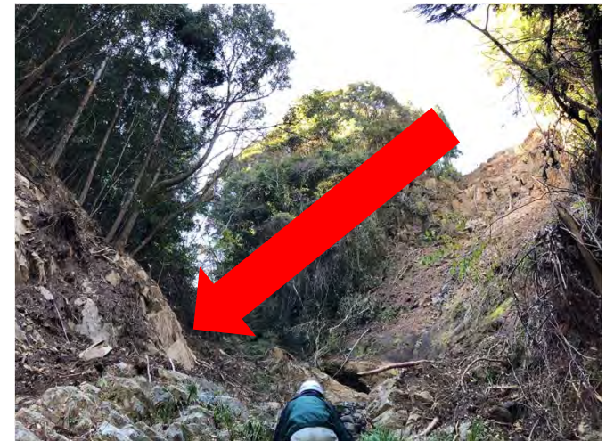
⑥流下時に削られた斜面 (③の溪流対岸)
