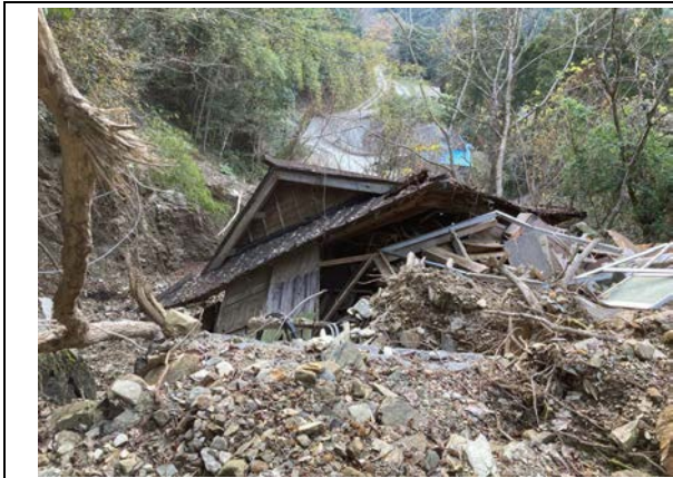
基礎部洗堀により倒壊した家屋A
