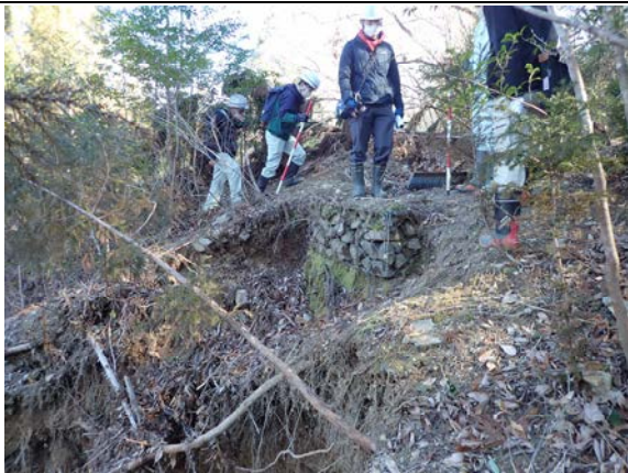
崩壊地上部の町道排水流末
