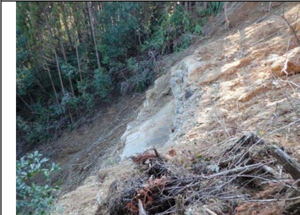
崩壊地上部の露岩状況
