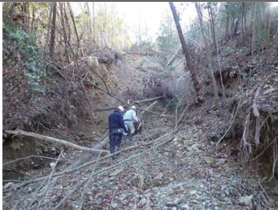
崩壊地の状況（崩壊残土の堆積）
