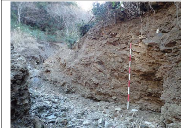
溪床内の侵食状況 (3m)
