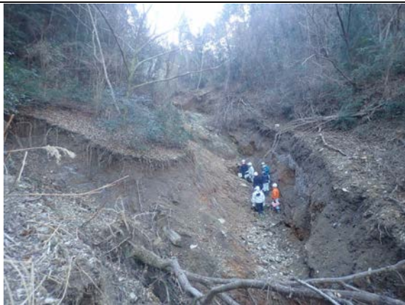
溪床内の侵食状況
