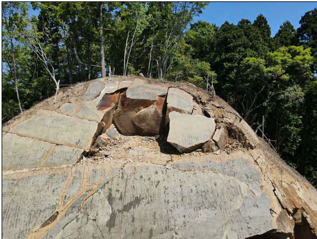
③斜面上部の崩壊（亀裂が発生し、押出されている）
