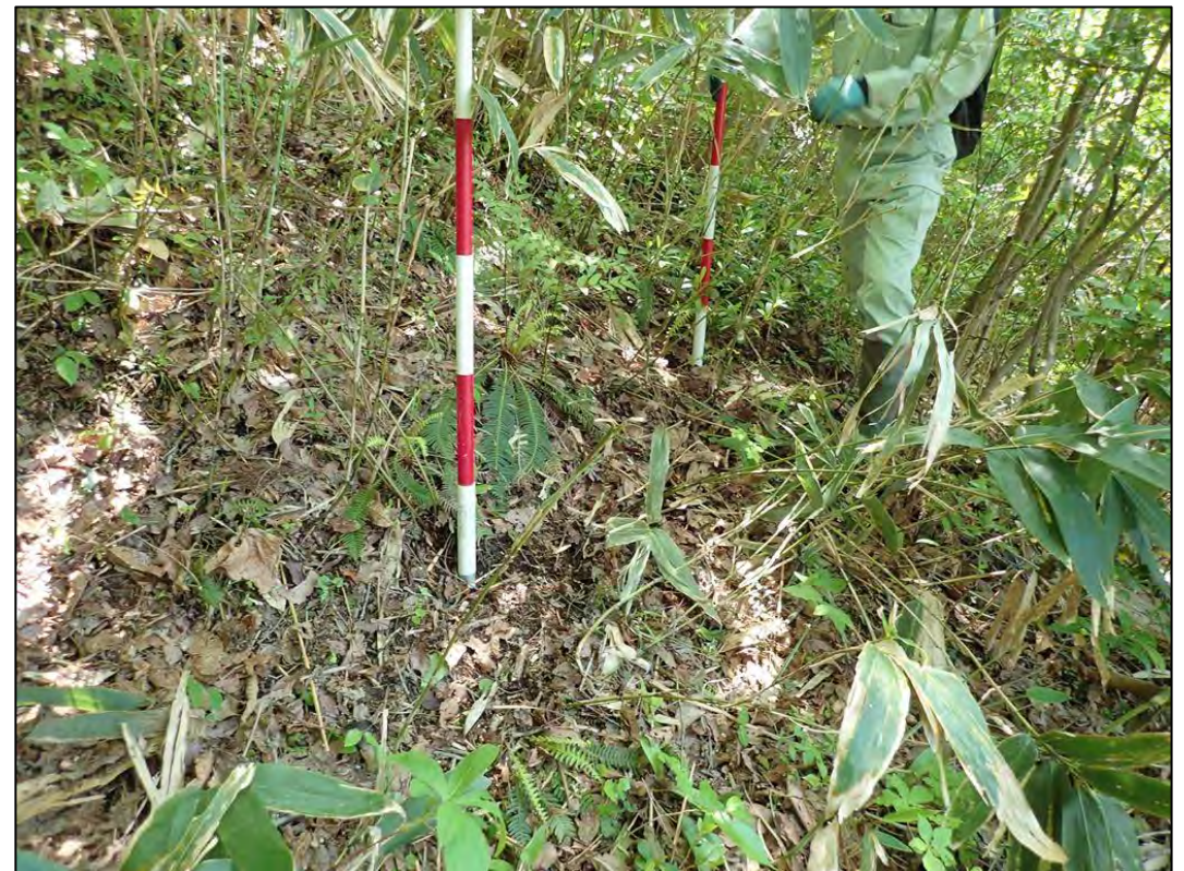
⑥崩壊地上部の緩み
