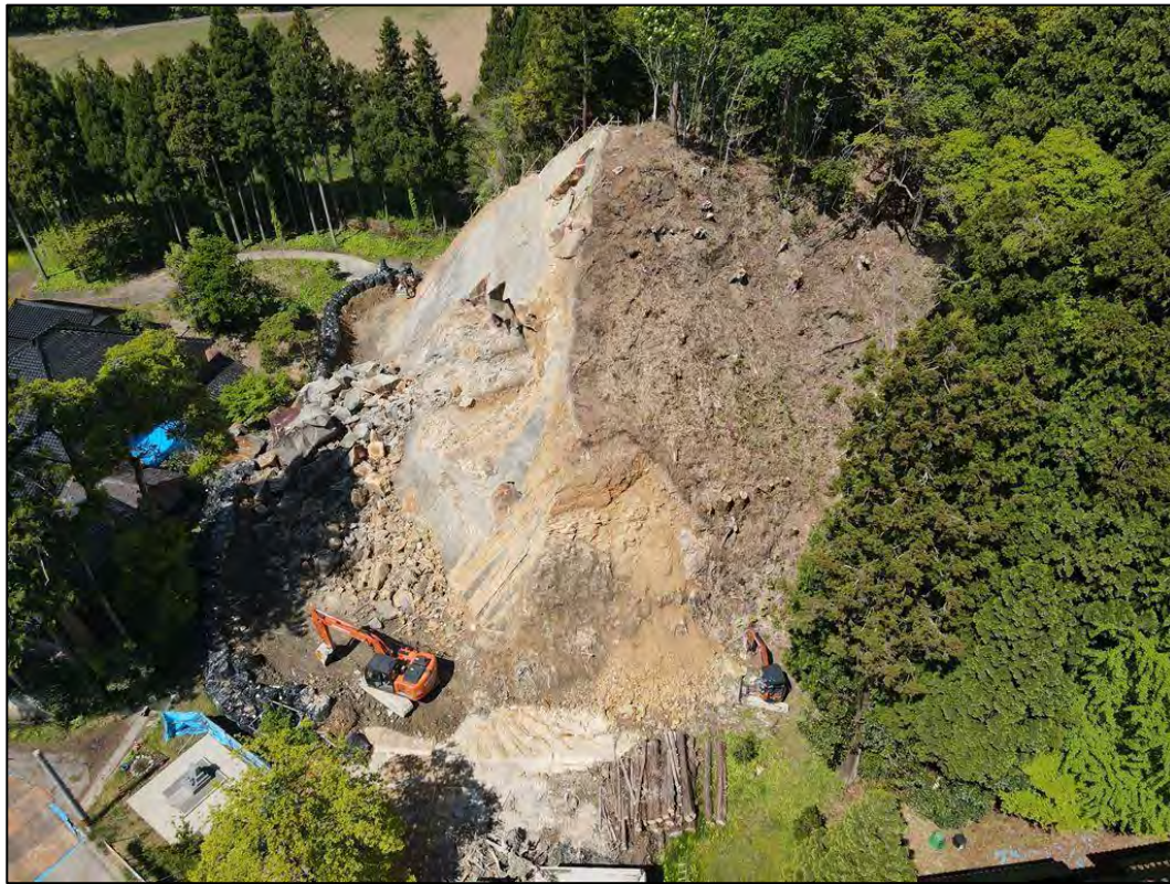
①崩壊地東側から撮影
