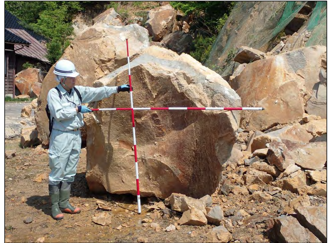
②崩壊した岩（ \phi=1.6\text{m} ）
