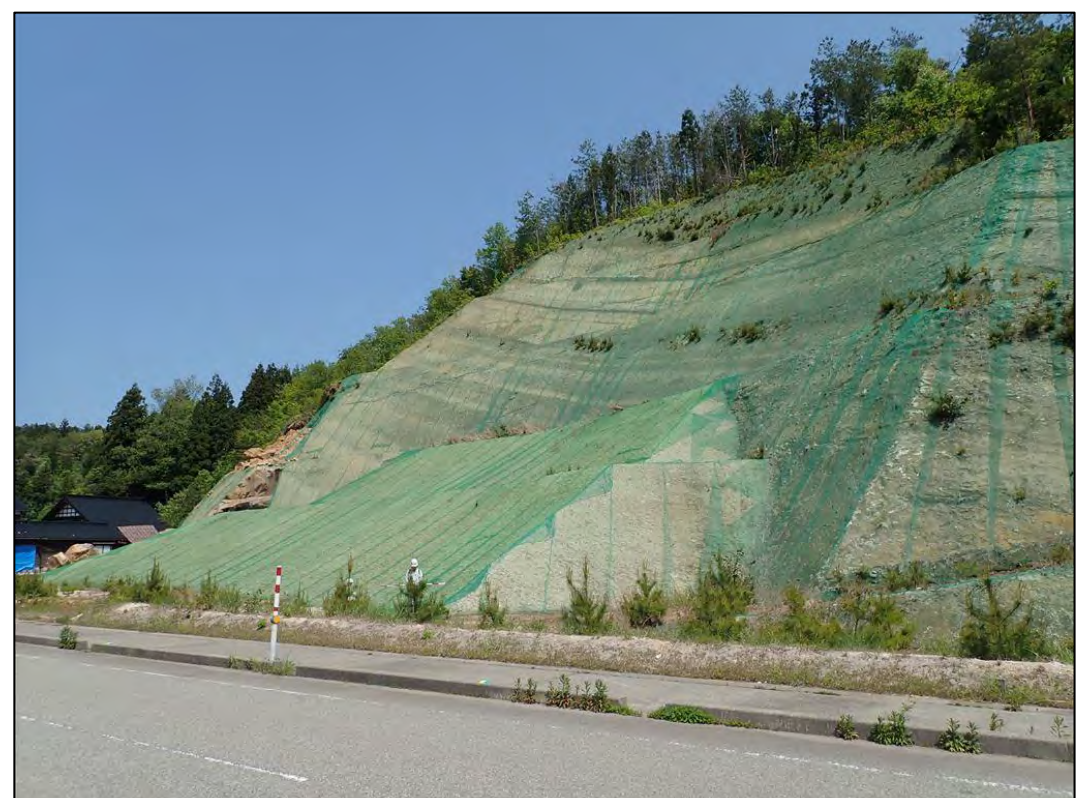
⑧切土斜面全景（切土 1 : 0.8 、下部は盛土 1 : 2 ）
