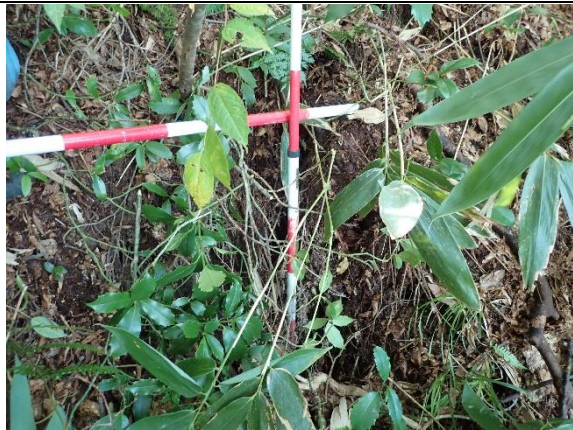
冠頭部直上部の開口亀裂（1.1m）
