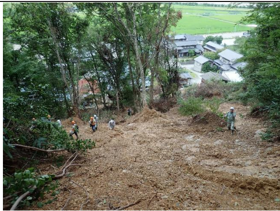
崩壊地と保全対象
