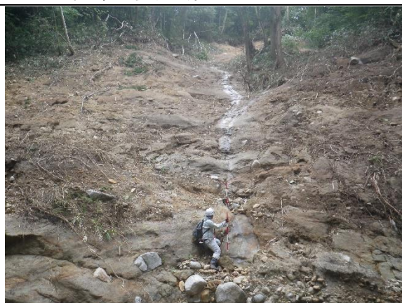
崩壊地内の基岩と崩壊上部からの湧水
