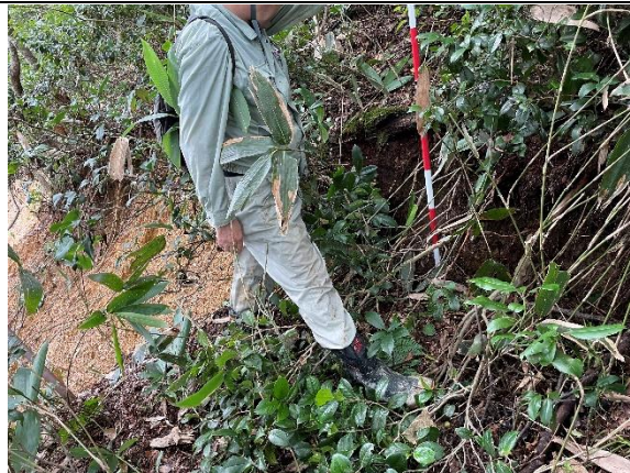
最上部の隣接崩壊地につながる開口亀裂（0.8m）
