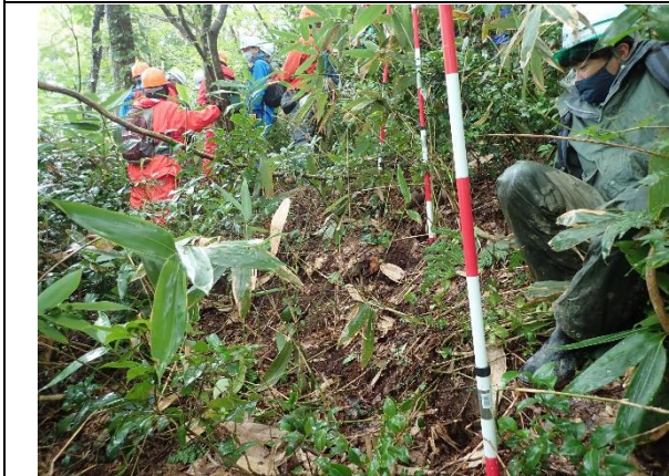
冠頭部上部斜面内の開口亀裂（0.4m）
