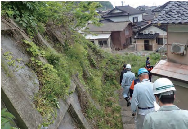
危険地区点検（山形県）
