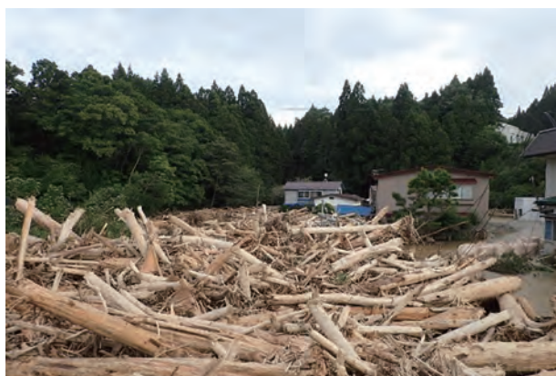
堆積した流木（小赤川）
