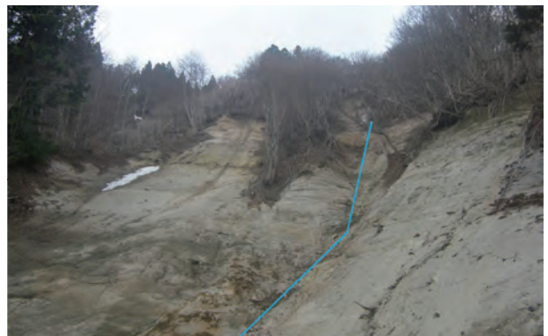
斜面上部の状況
