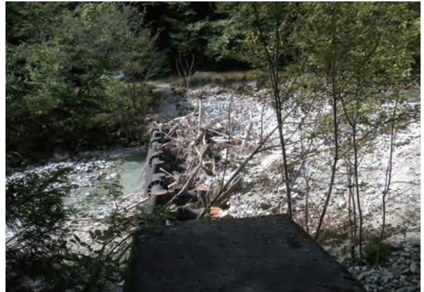
流木捕捉式ダムが流木及び土砂を捕捉した事例
