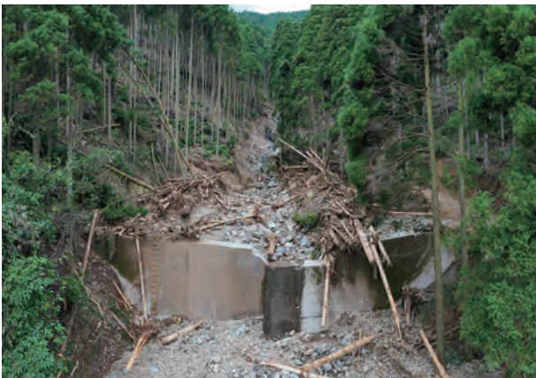
治山ダムが渓流の勾配を緩やかにしていたため流木流出を防止した事例
