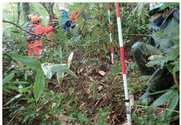
冠頭部上部斜面内の開口亀裂（0.4m）
