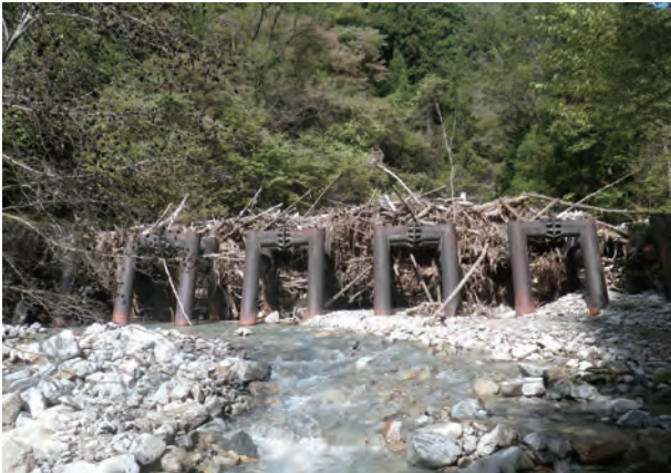
流木捕捉式ダムが流木及び土砂を捕捉した事例
