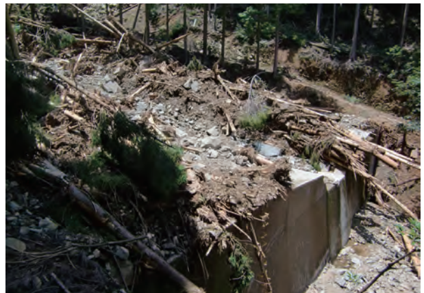
治山ダムが渓流の勾配を緩やかにしていたため流木流出を防止した事例
