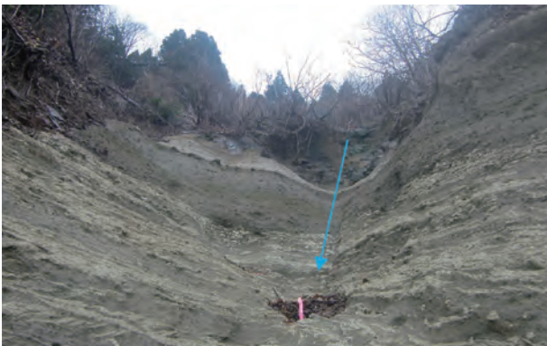
A 工区斜面中腹の基岩の状況
