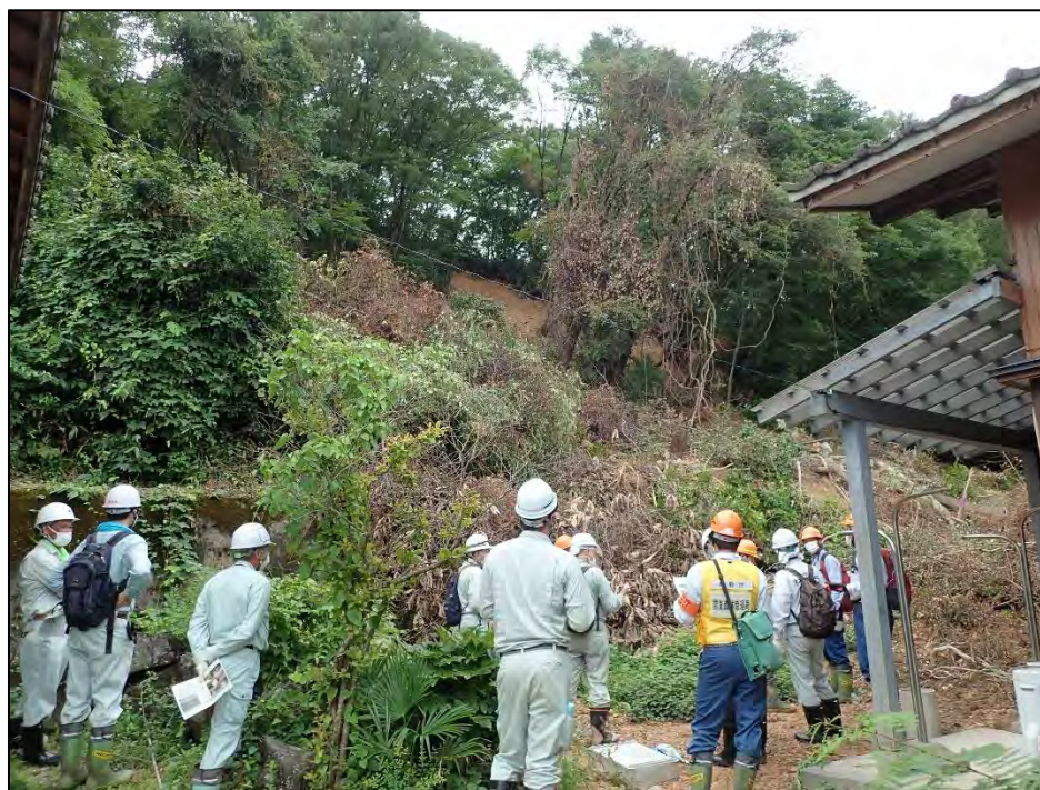
写真 2-1 緊急調査（一次調査（合同調査））実施状況
