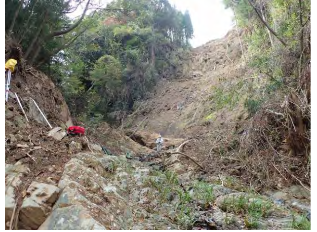
写真 2-9 崩壊地全景（吾味地区）
