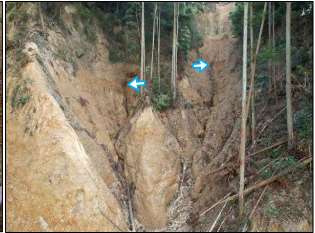
写真 2-14 溪流内侵食状況と湧水点とみられる凹地
