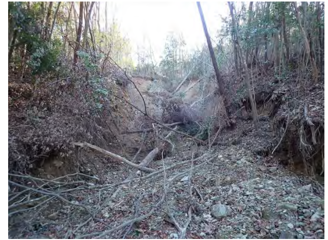
写真 2-11 崩壊地全景と堆積土砂（松の越地区）
