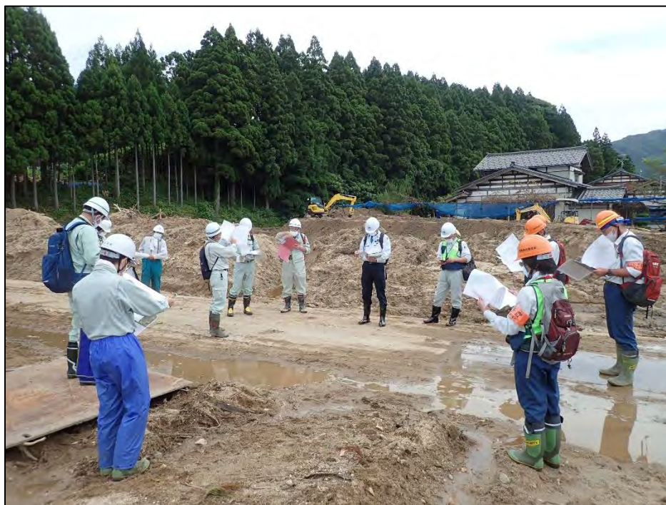
写真 2-2 緊急調査（二次調査）実施状況
