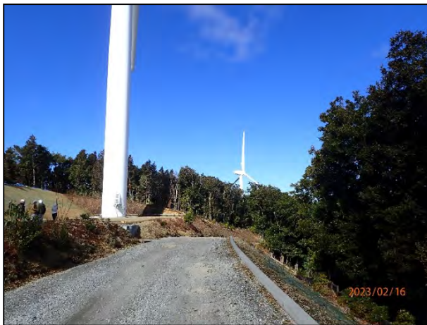
写真 7-27 5号機の風力発電機とそのヤードと林道
