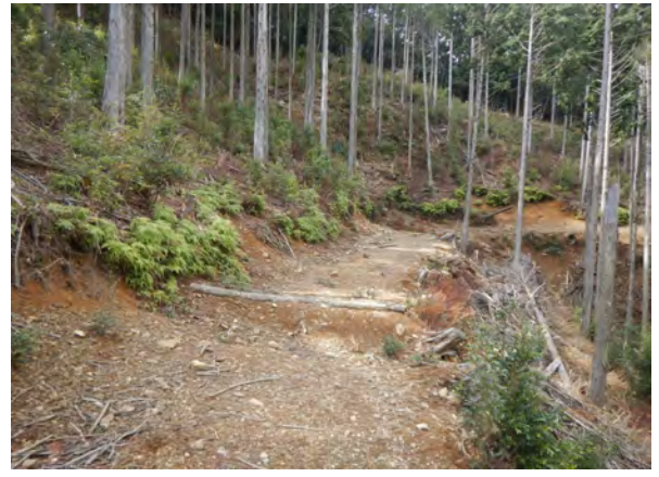
写真 7-58 林内路網の施工状況（緩傾斜地）
