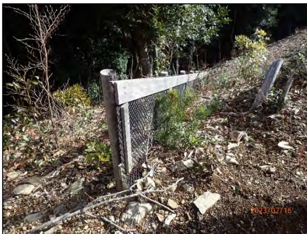
写真 7-29 5号機に至る林道沿いに設置されている編柵工の状況
