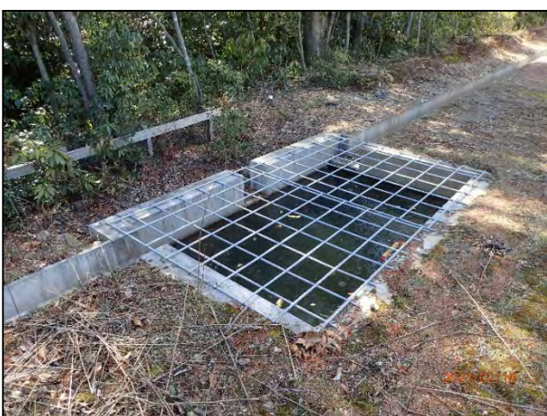
写真 7-35 6号機の貯砂施設・集水枡（民有林側）のかご枠及び編柵工の設置状況
