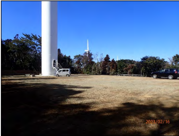
写真 7-21 4号機の風力発電機とそのヤード
