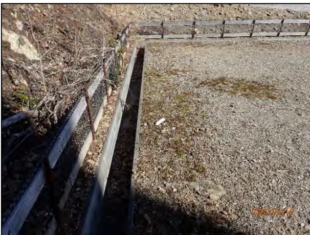
写真 7-47 8号機のヤード切土法面沿いの編柵工及びヤード末端の開渠水路の状況
