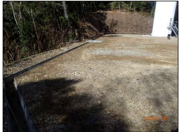
写真 7-46 8号機ヤード切土法面、及びヤード末端の開渠水路
