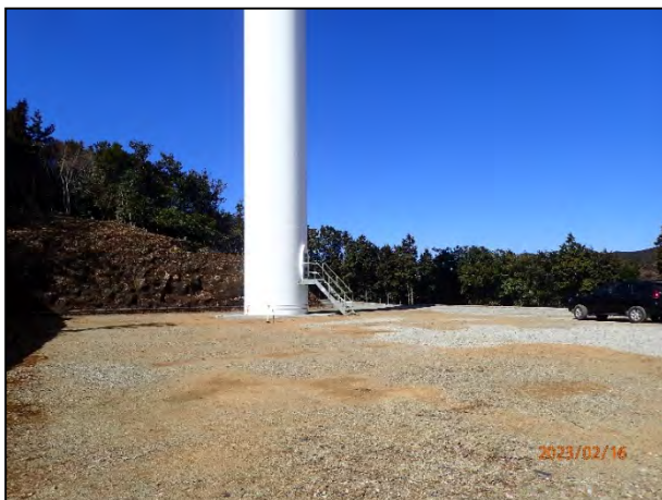
写真 7-3 1号機の風力発電機とそのヤード
