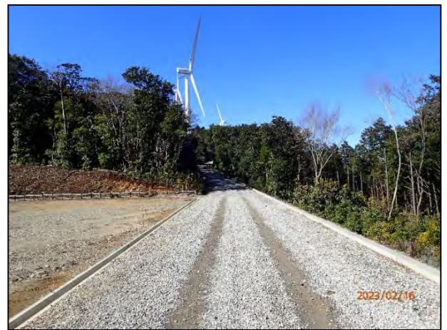
写真 7-42 7号機に至る林道の路面整備状況
