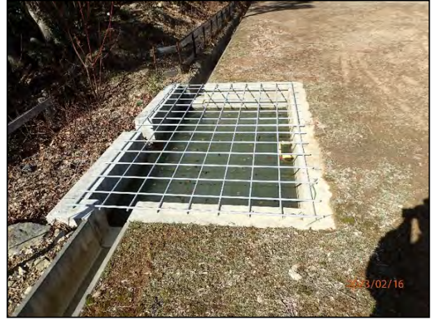
写真 7-44 8号機の貯砂施設・集水枡、かご枠及び編柵工（南側）の設置状況
