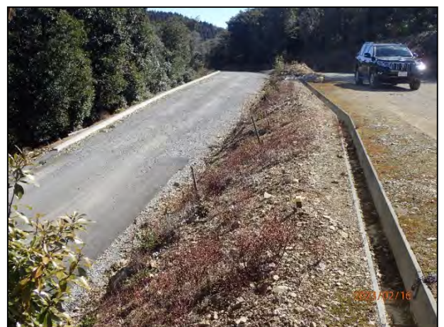
写真 7-18 3号機に至る林道の舗装区間と斜面の緑化状況
