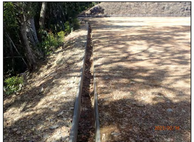
写真 7-10 2号機ヤード末端の開渠水路の状況
