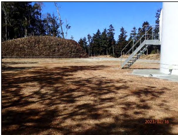
写真 7-9 2号機の風力発電機とそのヤード
