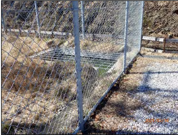
写真 7-49 変電所の貯砂施設・集水柵の設置状況
