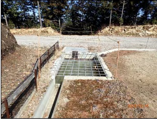
写真 7-7 2号機の貯砂施設・集水柵(国有林野側)の設置状況
