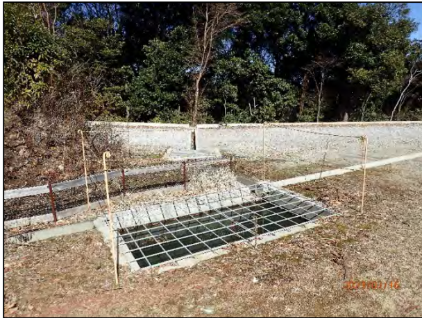
写真 7-31 6号機の貯砂施設・集水枡の設置状況
