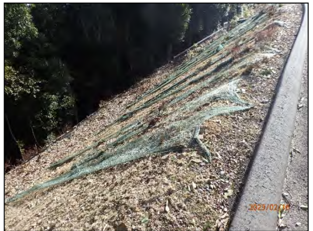
写真 7-28 5号機に至る林道の法面の緑化及び被覆シートの状況
