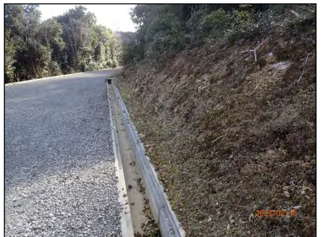
写真 7-30 5号機に至る林道と開渠排水路と法面の状況
