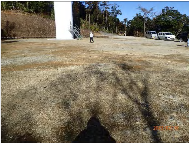
写真 7-45 8号機の風力発電機とそのヤード
