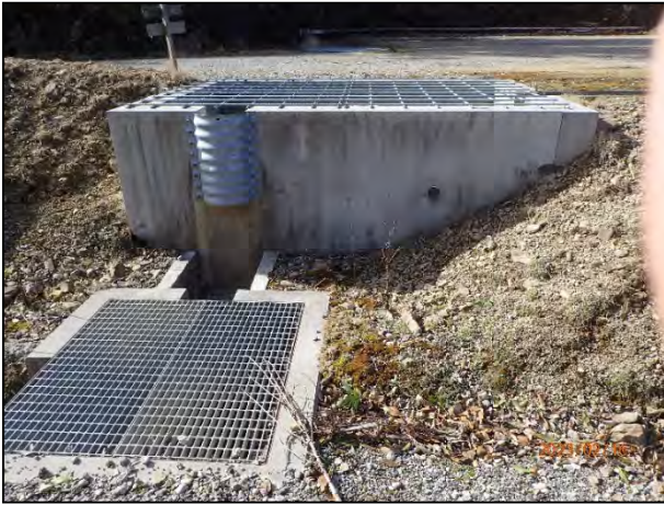
写真 7-25 5号機の貯砂施設・集水枡の設置状況
