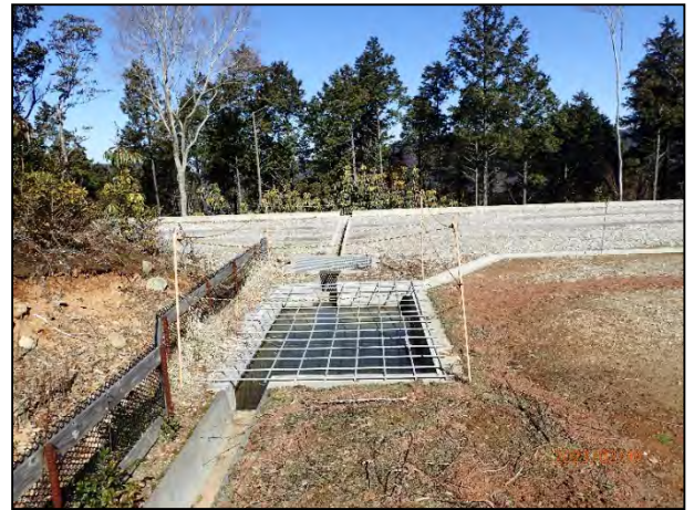
写真 7-40 7号機ヤード切土法面の前面の編柵工と貯砂施設・集水柵の設置状況
