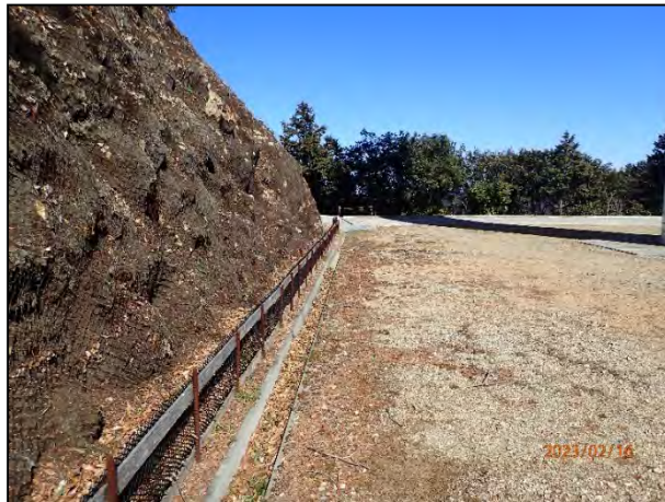
写真 7-4 1号機ヤード切土法面、編柵工及びヤード末端の開渠
