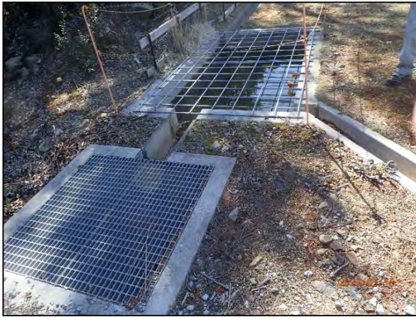
写真 7-37 7号機の貯砂施設・集水柵の設置状況
