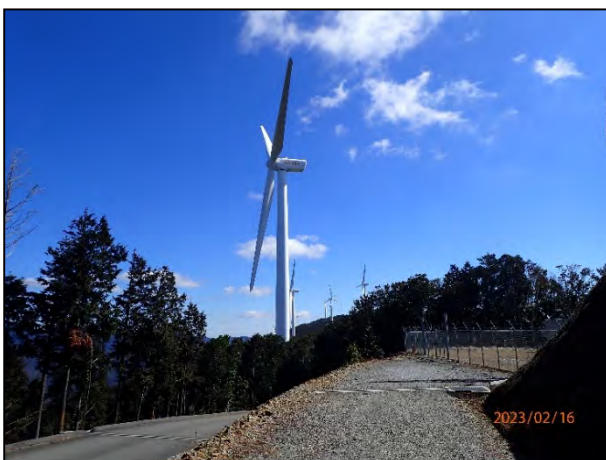
写真 7-53 変電所ヤードへの進入路（その左手に 見える1号機）
