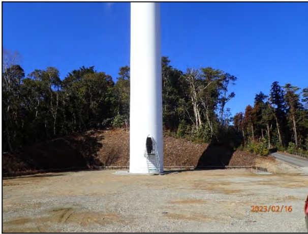
写真 7-39 7号機の風力発電機とそのヤード
