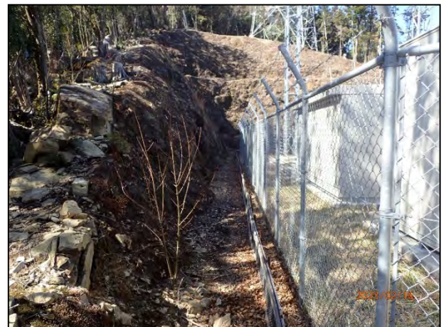
写真 7-52 変電所ヤードの南西側の切土法面、及 び編柵工の設置状況
