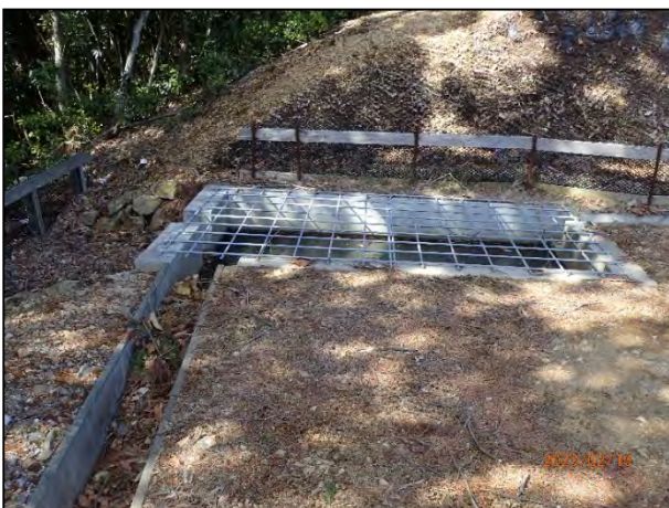
写真 7-11 2号機の貯砂施設・集水柵(民有林側)の設置状況
