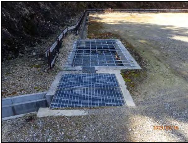
写真 7-13 3号機の貯砂施設・集水柵の設置状況
