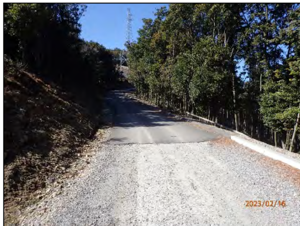
写真 7-6 1号機に至る林道の舗装区間と砂利区間の状況
