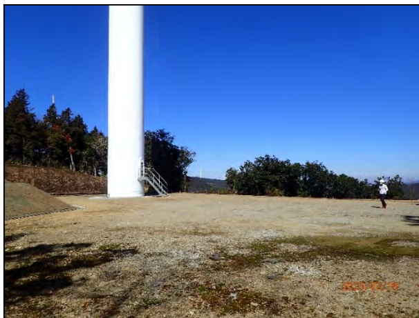
写真 7-15 3号機の風力発電機とそのヤード
