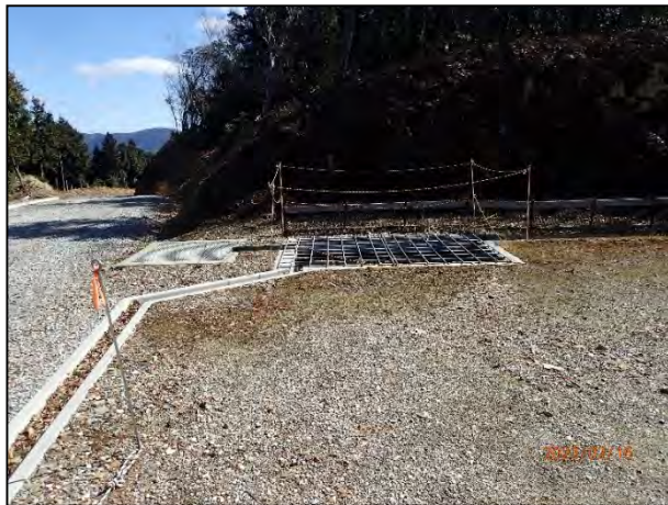
写真 7-1 1号機の貯砂施設・集水枡の設置状況
