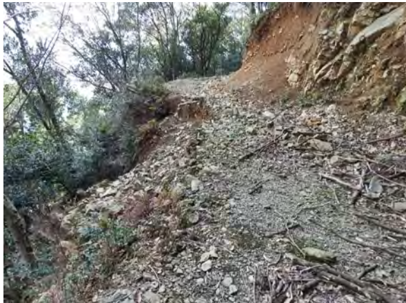
写真 7-57 林内路網の施工状況（急傾斜地）
