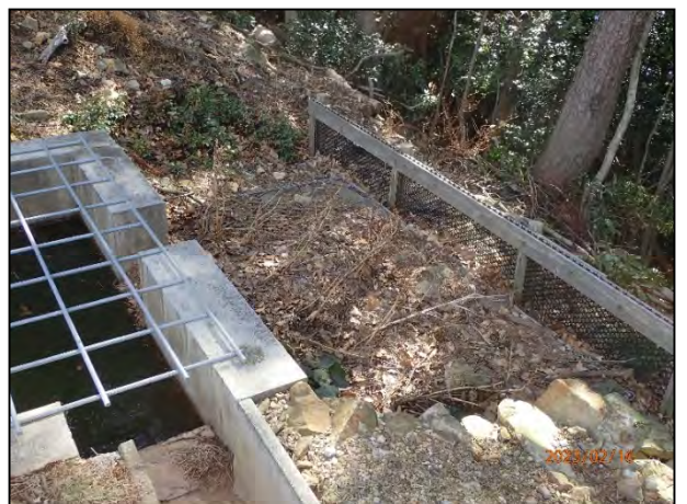
写真 7-12 2号機の集水柵(民湯林側)から出る越流水を受け止めるかご枠と編柵工
