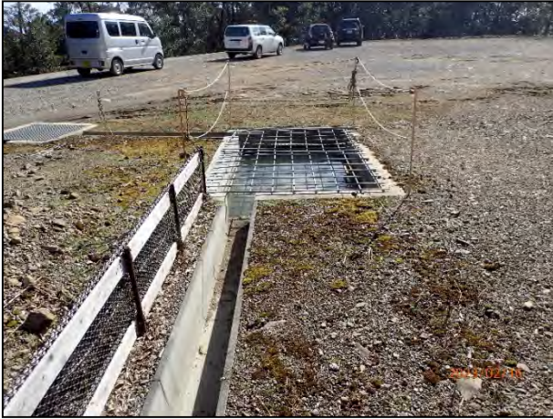
写真 7-43 8号機の貯砂施設・集水枡（北側）の設置状況
