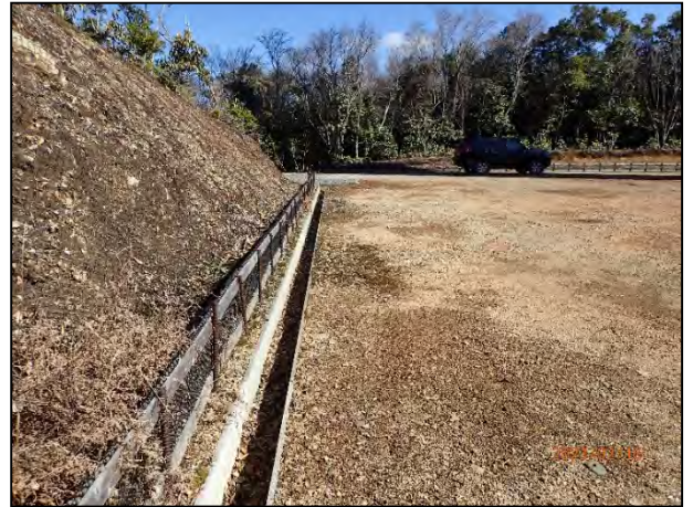
写真 7-22 4号機ヤード切土法面、編柵工及びヤード末端の開渠水路
