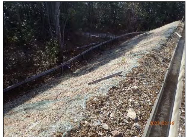
写真 7-48 8号機に至る林道沿いの法面とそれに平行して設置されている編柵工
