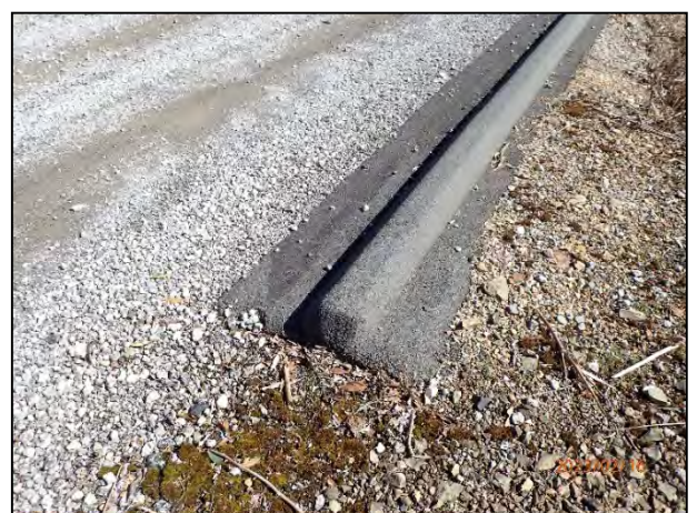
写真 7-36 6号機に至る林道脇の路面水の林道外越流防止のためのアスカーブ
