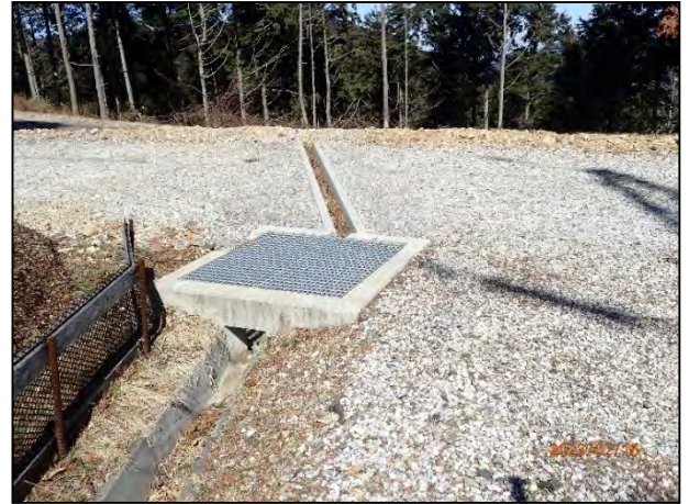
写真 7-50 集水柵通過後に流入する集水柵と通路 上の横断排水溝
