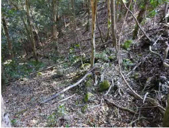
写真 7-55 林道の直下付近
