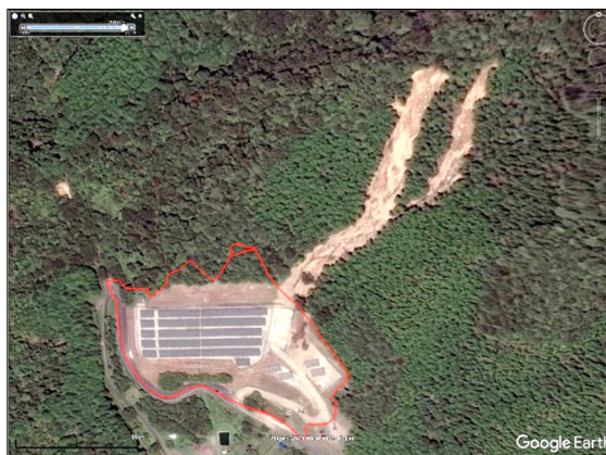
写真 5.7 域外からの土砂入流によって被災した事例
