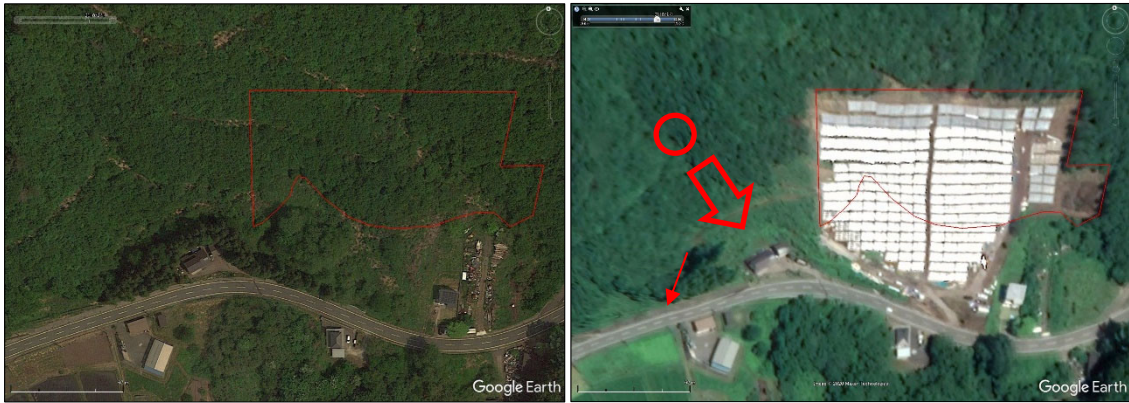
写真 5.8 太陽光発電施設以外からの土砂流出を、施設由来と報告された事例(1)
