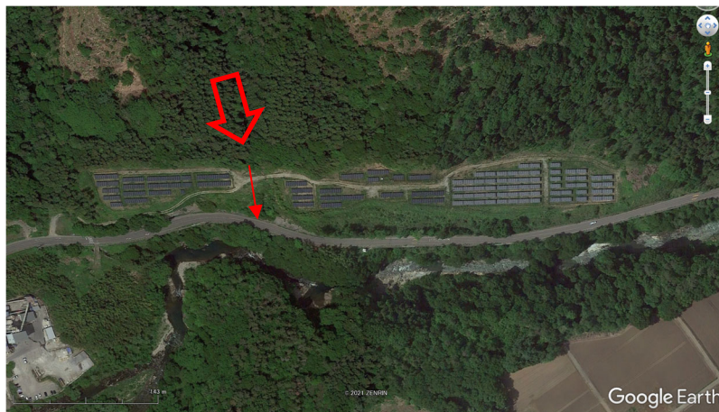
写真 5.9 太陽光発電施設以外からの土砂流出を、施設由来と報告された事例(2)
