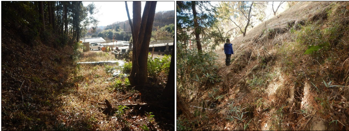
写真 5.12 事例(3)詳細:墓地に配置された土嚢と土砂崩壊発生源 群馬県の事例として墓地に土砂が流入した。斜面上部の太陽光発電施設の発生土砂とされていたが、実際は、墓地から50m程度離れた梅林斜面が崩壊し、土砂を流出させていた。
