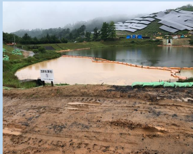
シルトフェンスを二重に設置
