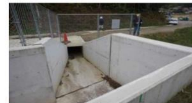
用水路の整備
