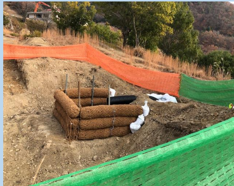
沈砂池とバイオフィルターの設置
