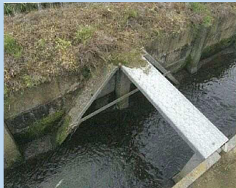
小動物移動機能付き水路の設置
