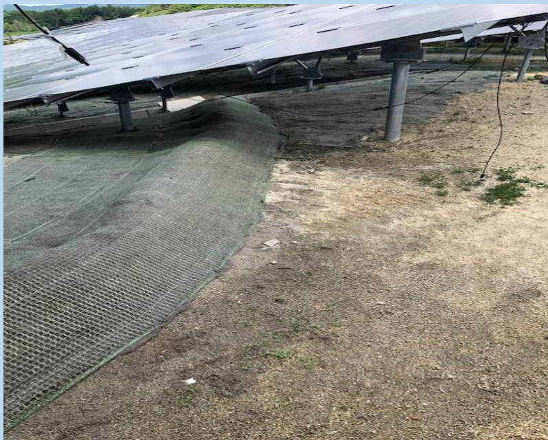
小堰堤による排水路までの導水路
