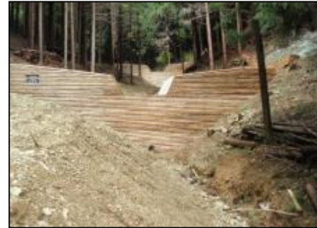
治山ダムの設置状況
