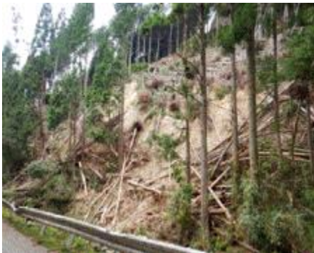
平成30年台風21号等による風倒被害に加え 令和2年7月豪雨により表層崩壊が発生 (京都府内の状況)
