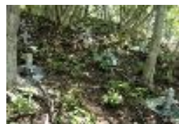
斜面を補強する対策
