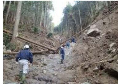
例) 令和元年東日本台風 宮城県丸森町(溪流の縦浸食2~3m)
