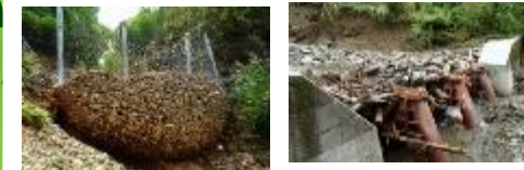
(参考)ワイヤーネットやスリットダムによる土石や流木の捕捉
